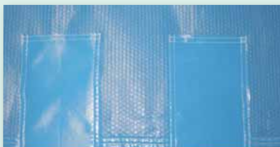
Cajeado de refuerzo para escalera
